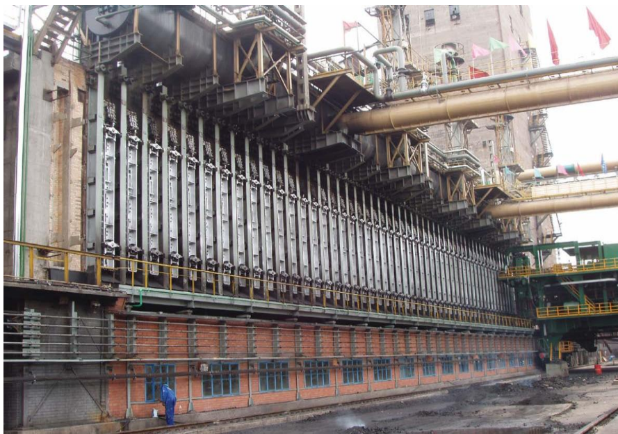
中信建设集团承包的南非焦炉改造项目
