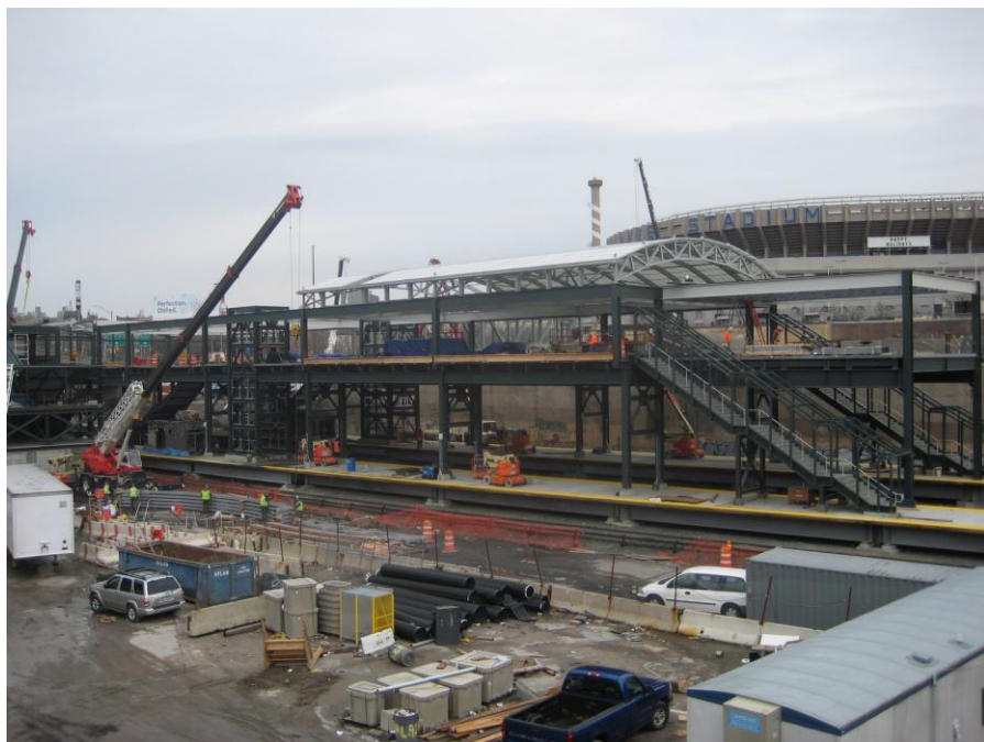
施工中的纽约洋基体育场火车站
