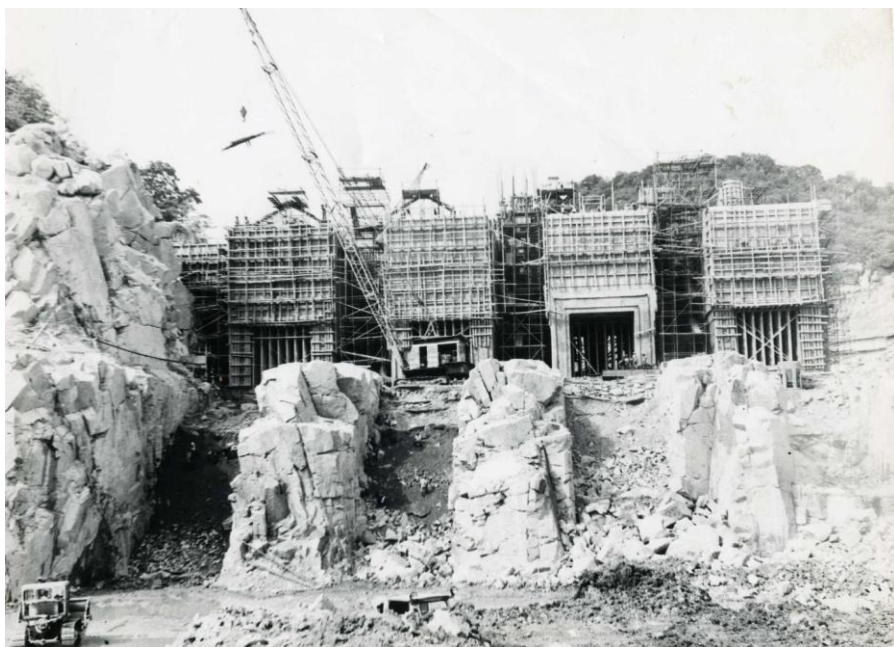
拉克都水电站
